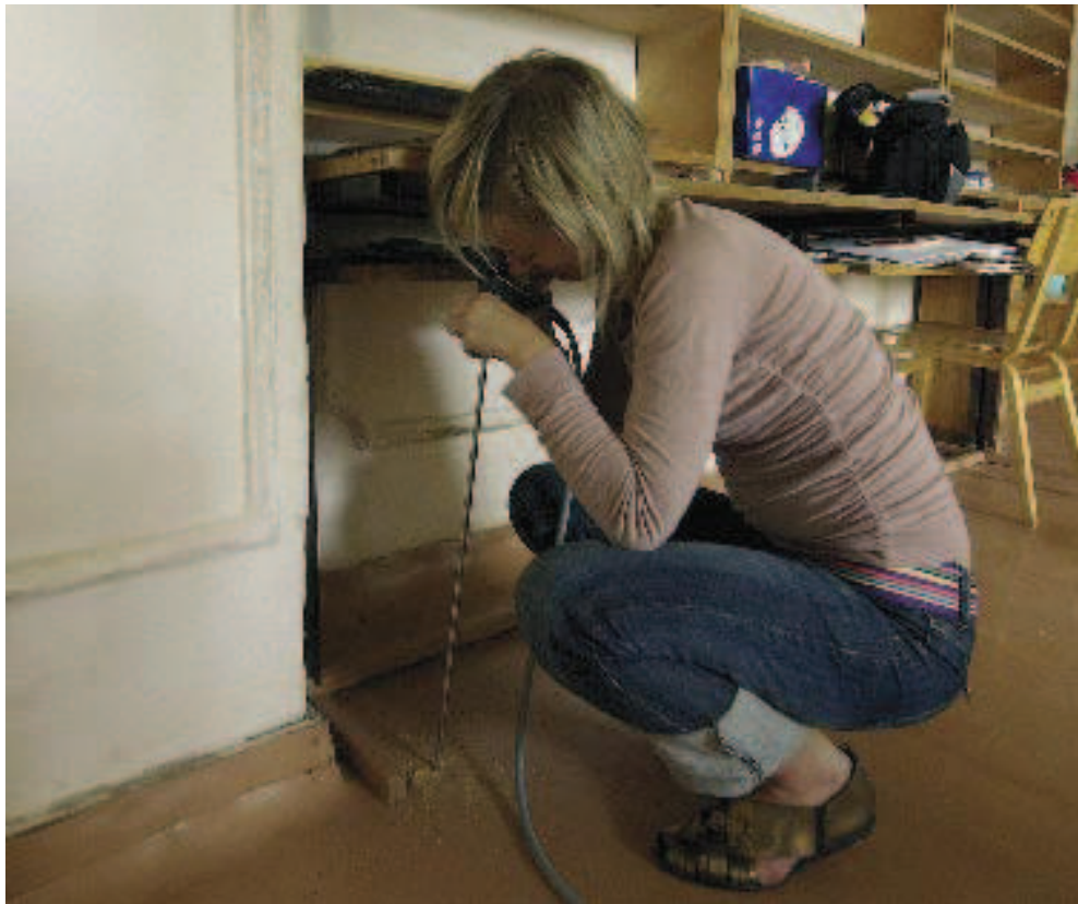
Põrandaaluse konstruktsiooni kontrollimine fiiberoptilise boreskoobiga. Fotod: Kalle Pilt
